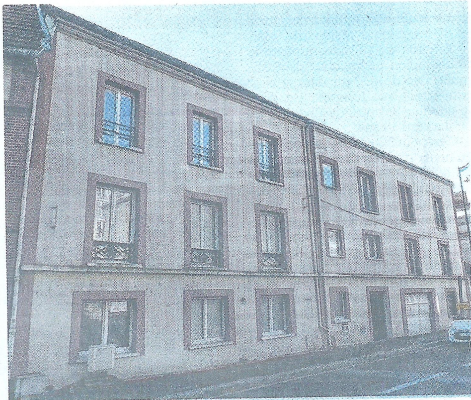
Saint-Maurice, 74, rue du Maréchal-Leclerc. Le propriétaire de cet immeuble est une société du Luxembourg. Cela fait cinq ans qu'elle doit y faire des travaux. (LP/ML.)
